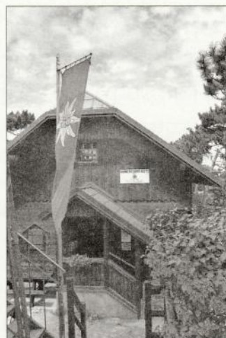
Kammersteinerhütte nach der Renovierung 2000
